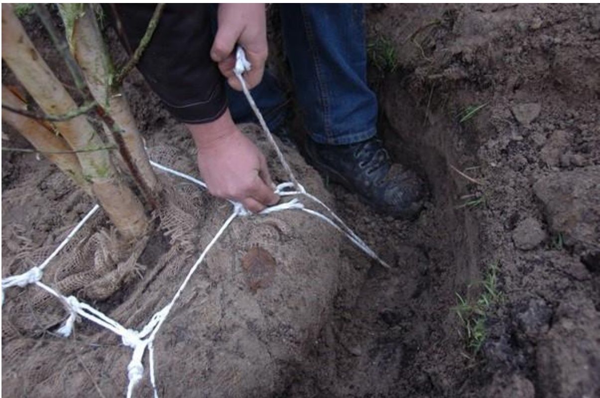
Een boomkluit die strak vast wordt gezet aan de Eco Keepers
