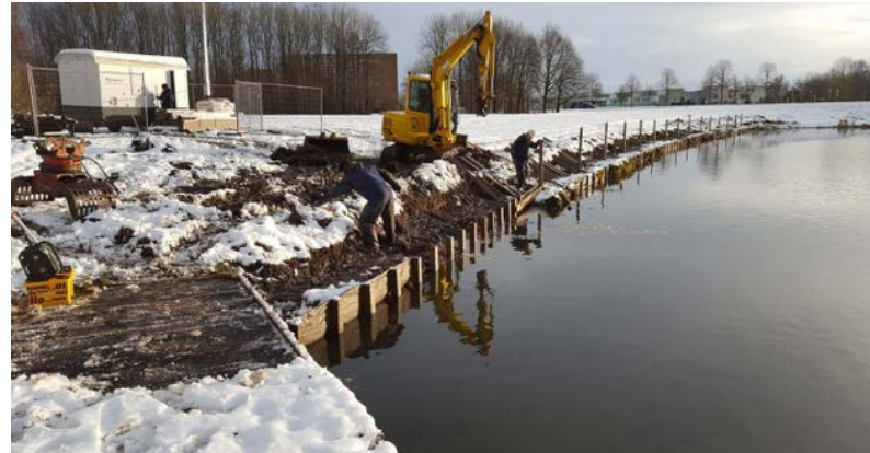
Afbeelding 5. Biobased walbeschoeiing Gemeente Almere.
